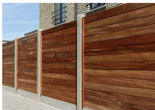
Massief scherm okan in betonnen gleufpalen met plaat onderaan
