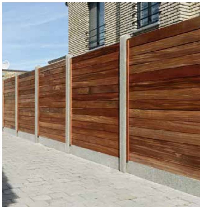
Omheining met massiefplanken okan in betonnen gleufpalen
